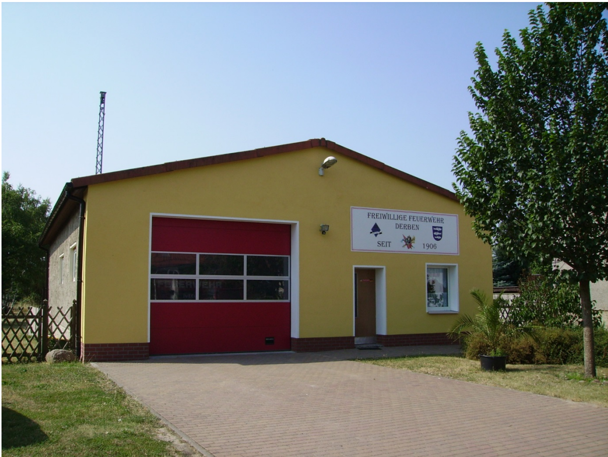
Bild 2 - Ansicht des Feuerwehrhaus Derben
