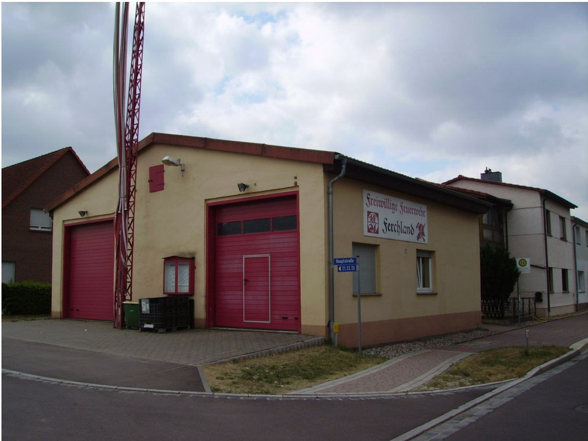
Bild 4 - Ansicht Feuerwehrhaus Ferchland
