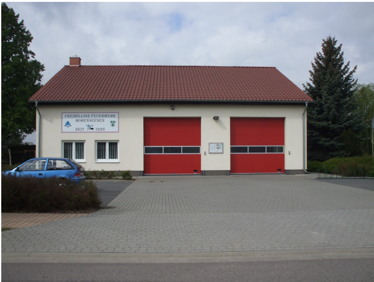
Bild 7 - Ansicht Feuerwehrhaus Hohenseeden
