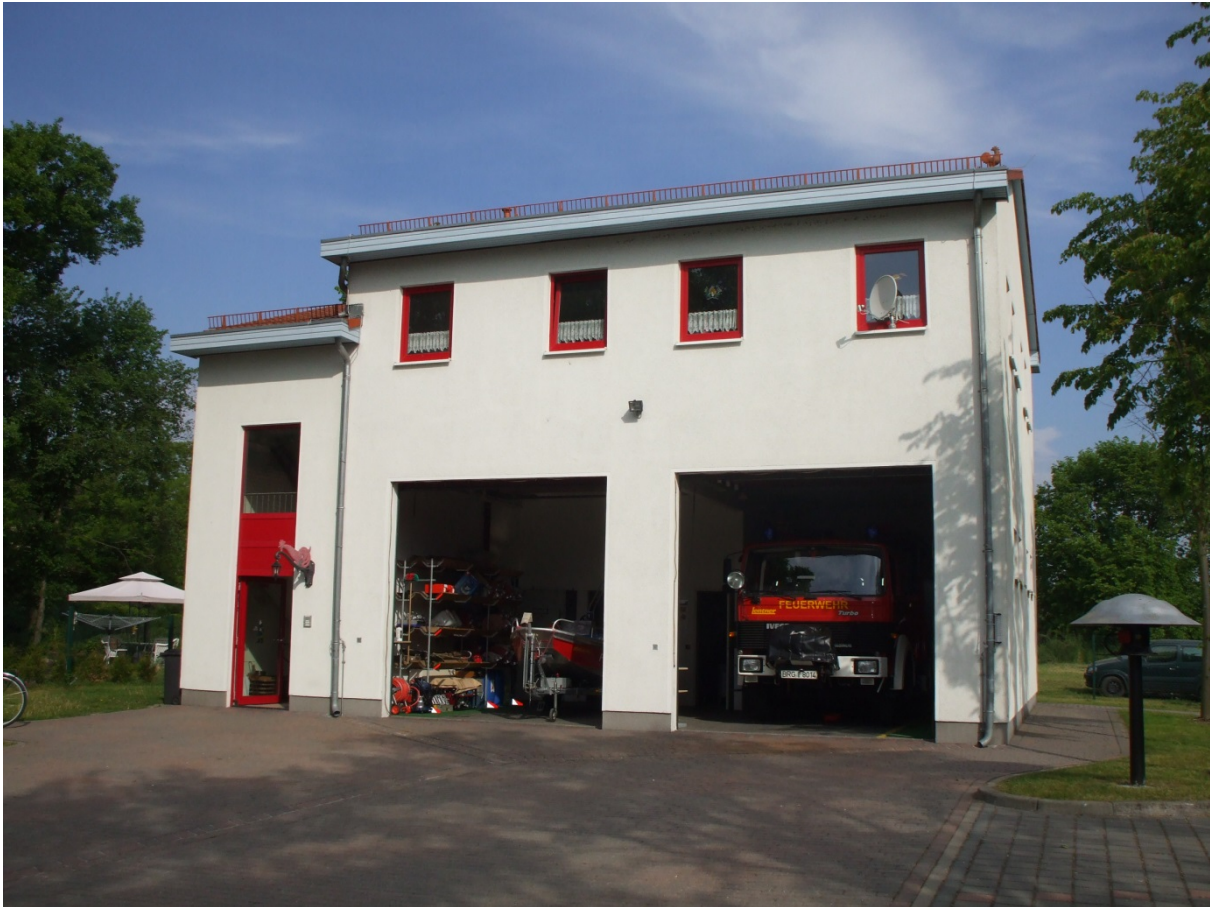
Bild 11 - Ansicht Feuerwehrhaus Zerben
