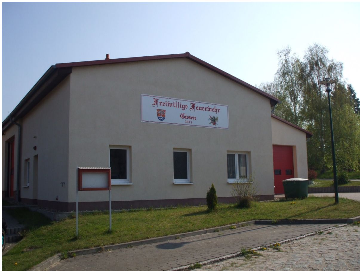
Bild 5 - Ansicht Feuerwehrhaus Güsen
